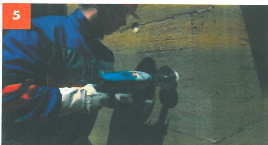
Ancorarea plăcilor din vată minerală pe substratul de suport
